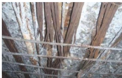
PC鋼材の破断
